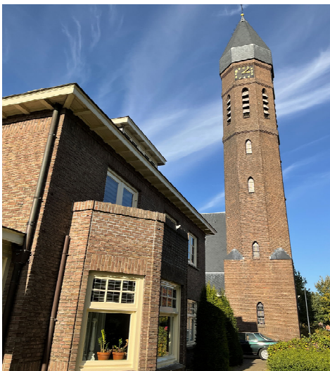
Figuur 8: Overzichtsfoto bebouwing
