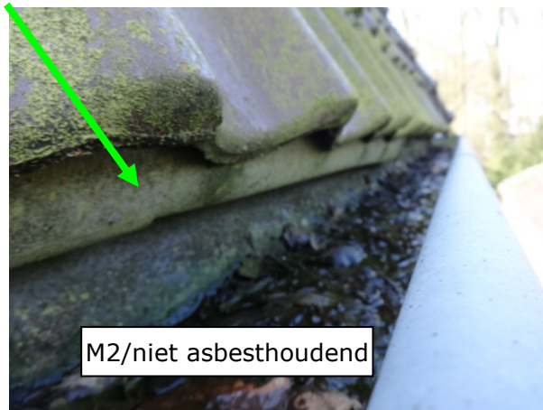
Afbeelding 7: nr 47 kerk/ buitenzijde/bitumen vogelschroten dak
