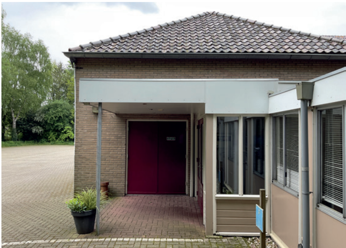
Achteringang zalencomplex De Esch
