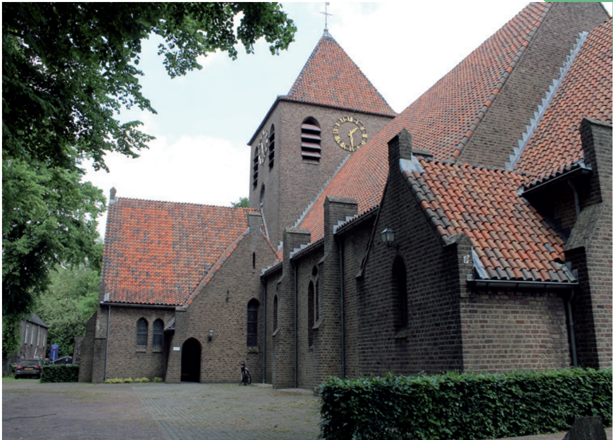
Kerkgebouw H. Mattheüs
