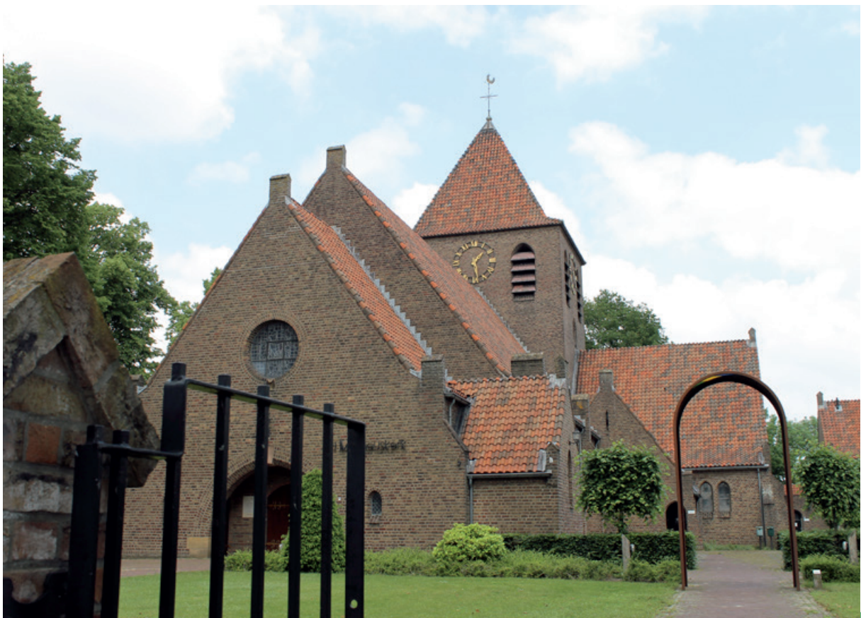
Kerkgebouw H. Mattheüs
