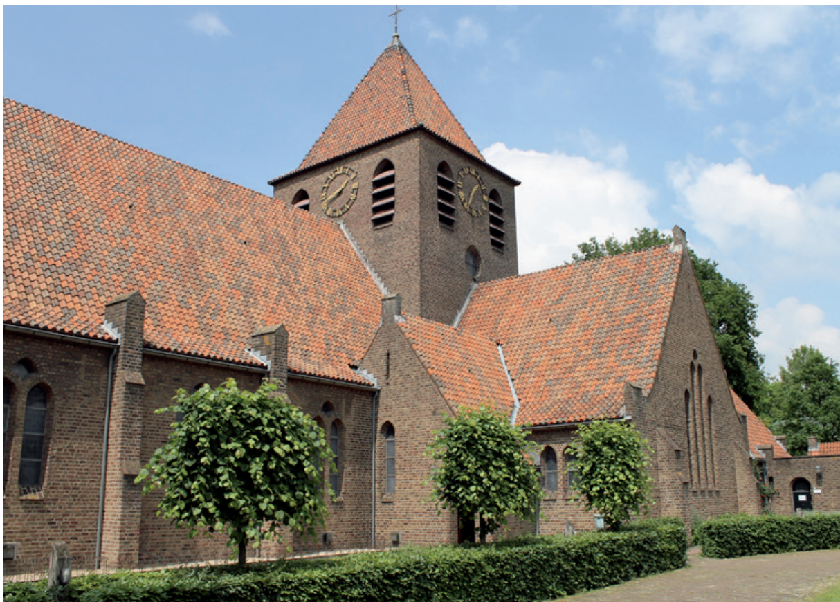
Kerkgebouw H. Mattheüs
