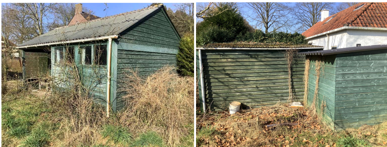
Afbeelding 3.1: Linker foto: asbestgat bij regenpijp geplaatst. Rechter foto: asbestgat bij de hoek van het kleine groene schuurtje geplaatst.
